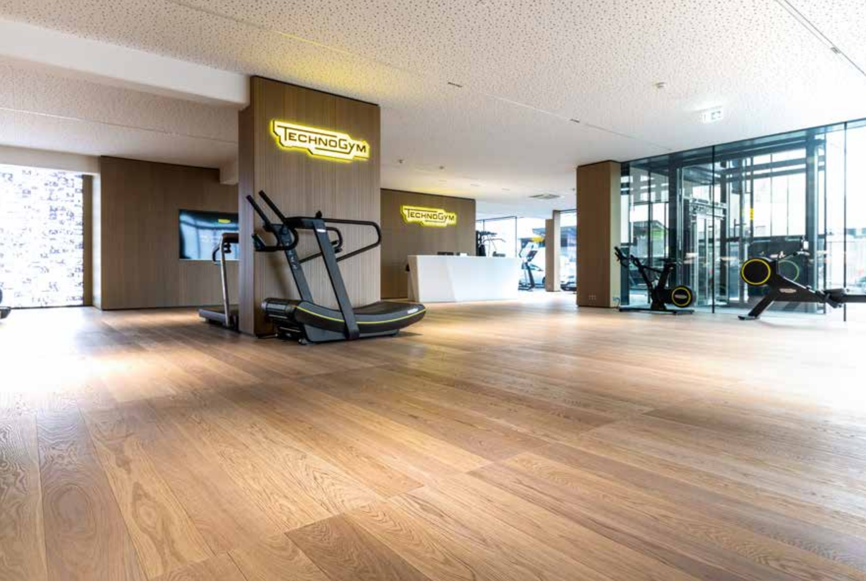
200 cm lange Eichendielen, astrein, gebürstet, Farbton Carezza, in Mischbreiten 16/19 cm hochkant (!) verlegt.
